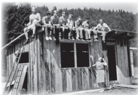
Construction du Club House
